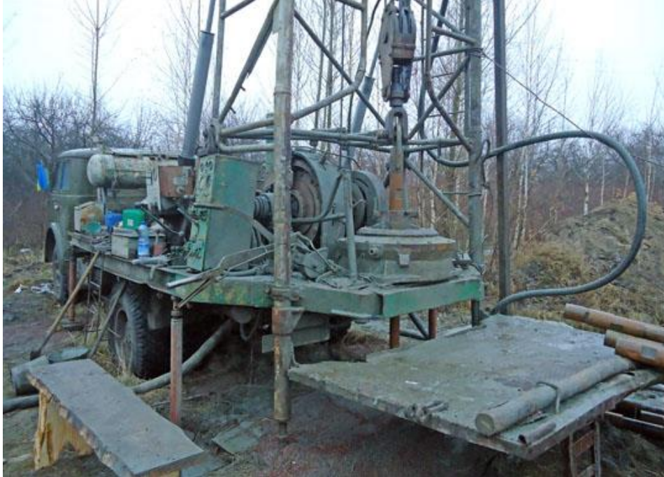
Проведення робіт з тампонажу недіючих артезіанських свердловин
